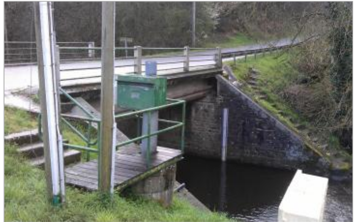
Station limnimétrique du Trieux à Saint-Péver Pont de Locminé
