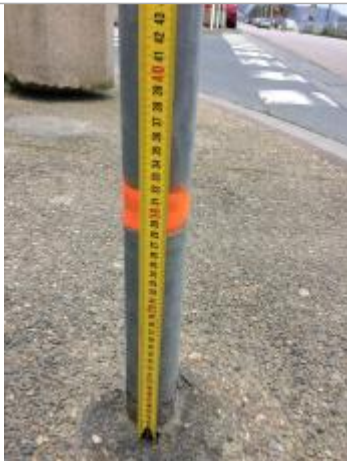
Laisse de crue à 28 cm/sol.
