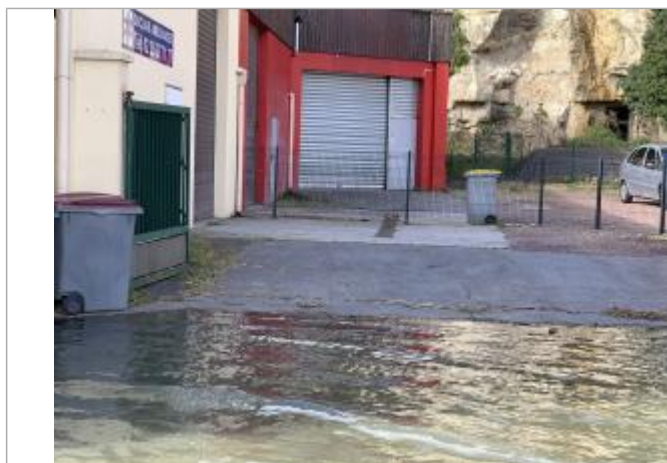
laisse de crue sur le trottoir au droit du 36 quai de la libération
