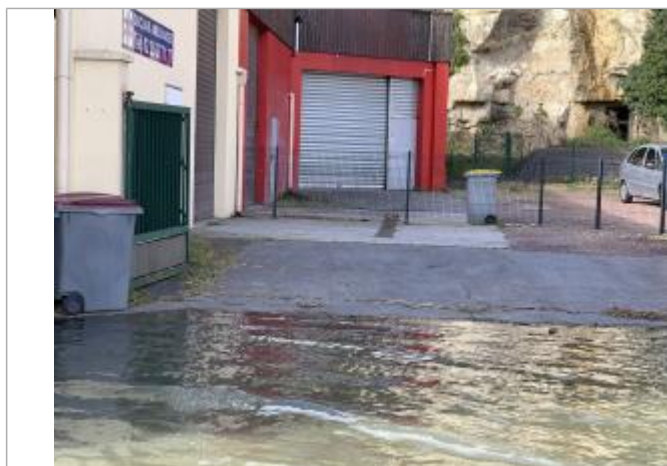
laisse de crue sur le trottoir au droit du 36 quai de la libération
