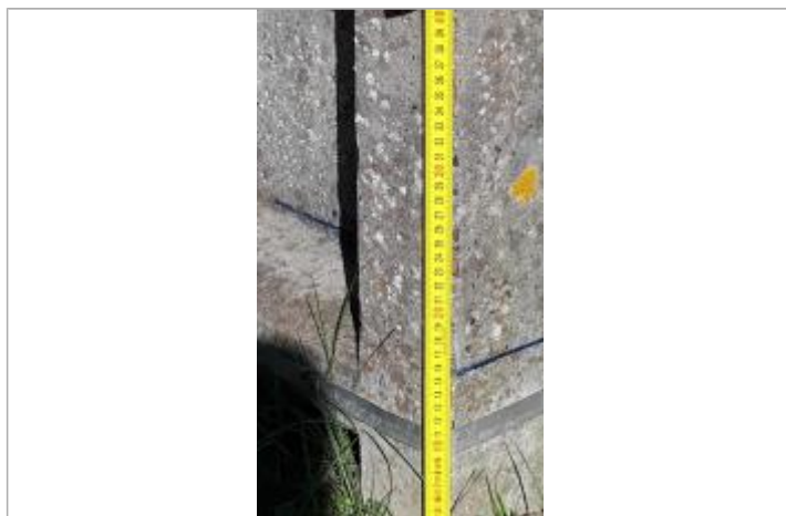
niveau de l'eau à 15,5 cm du sol
