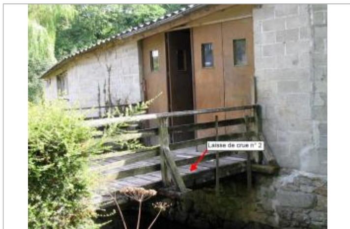
Passerelle du Moulin (photo de 2004)
