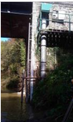
Station limnimétrique du Leff à Yvias et Quimper-Guézennec
