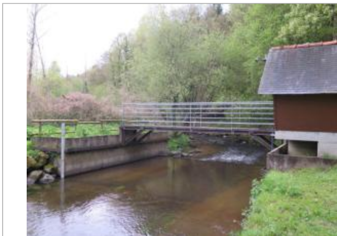
Station limnimétrique du Gouët à Saint-Julien
