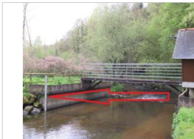
Station limnimétrique du Gouët à Saint-Julien
