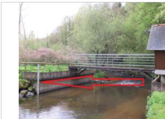
Station limnimétrique du Gouët à Saint-Julien
