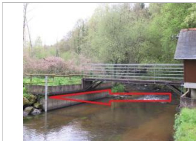
Station limnimétrique du Gouët à Saint-Julien
