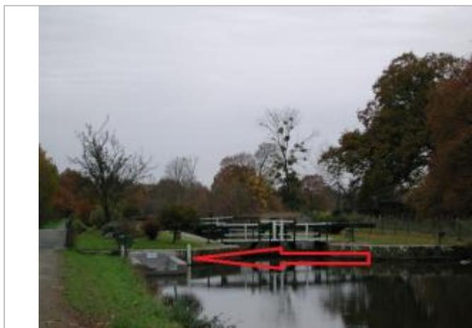
Echelle limnimétrique sur le bajoyer amont de l'écluse de Haut-Chalet à Betton
