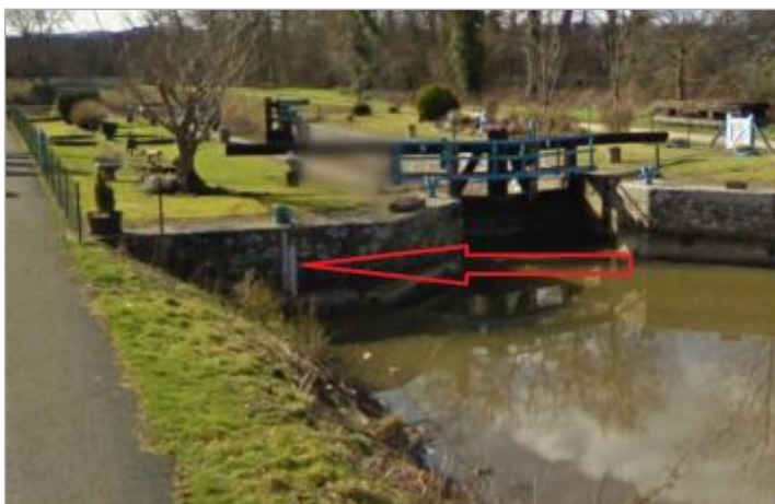
Echelle limnimétrique sur le bajoyer amont de l'écluse du Gacet à Betton
