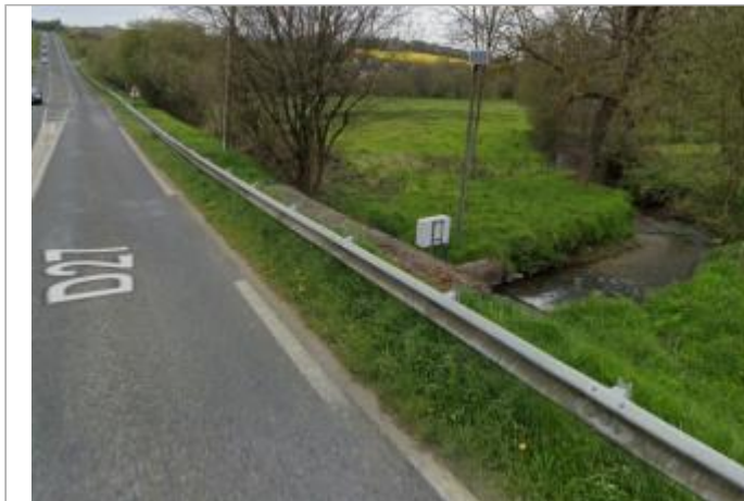
Station limnimétrique de l'Urne à Plédran
