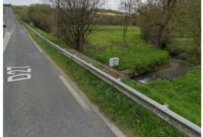
Station limnimétrique de l'Urne à Plédran
