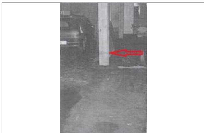
Laisse de crue sur la colonne à l'intérieur du garage automobile en 2000
