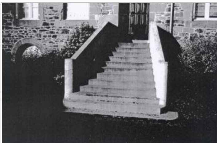
marches de l'escalier d'entrée au château de Lescouët en 2000
