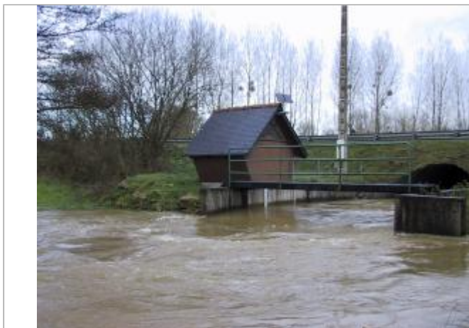
Station limnimétrique de la Rosette à Mégrit
