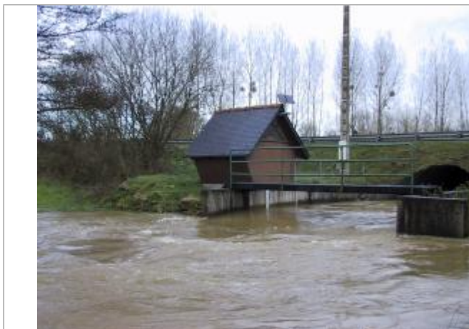
Station limnimétrique de la Rosette à Mégrit
