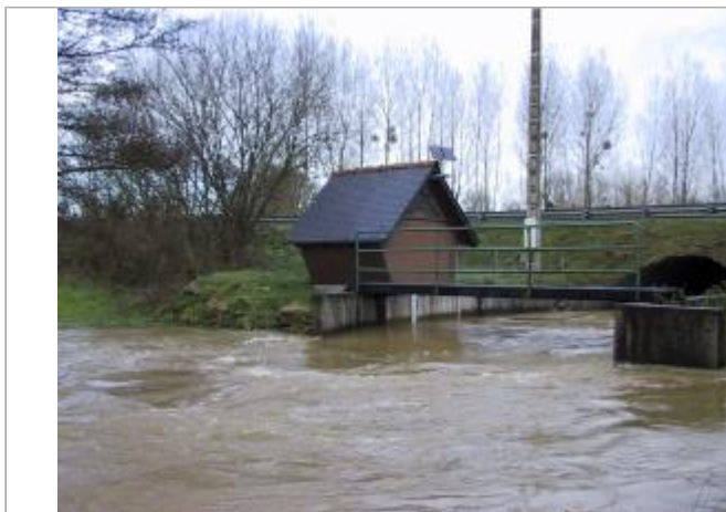
Station limnimétrique de la Rosette à Mégrit
