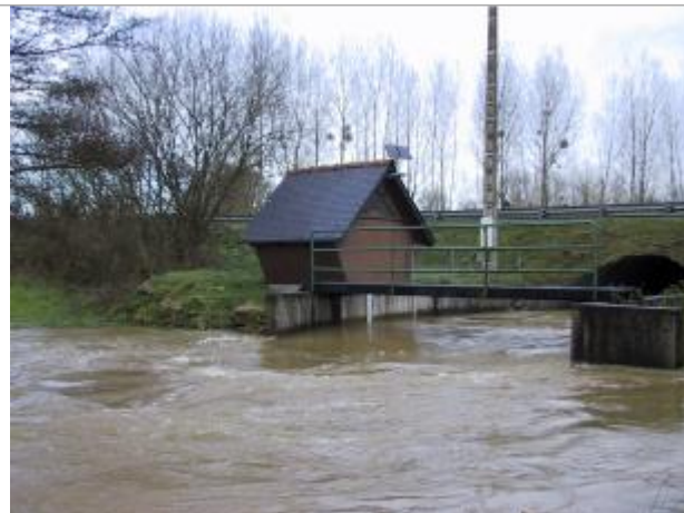
Station limnimétrique de la Rosette à Mégrit
