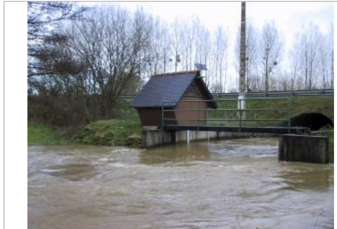
Station limnimétrique de la Rosette à Mégrit
