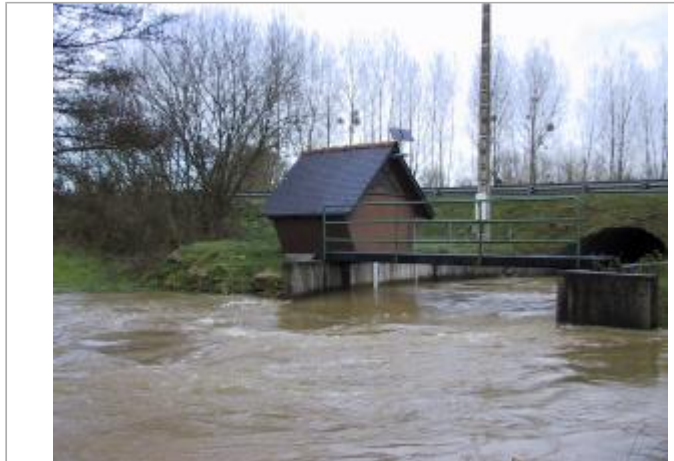
Station limnimétrique de la Rosette à Mégrit
