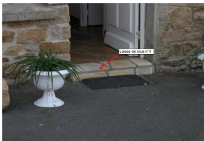
dessus de la marche de la porte d'entrée de l'habitation prise en 2004 par BCEOM
