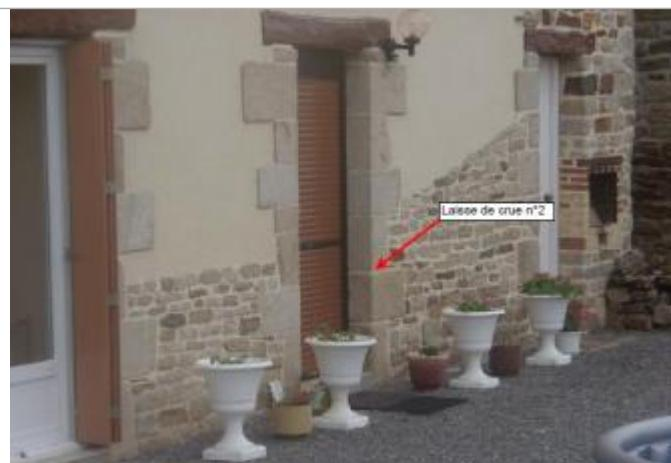
Photo de 2004 lors du relevé du témoignage de la laisse de crues sur le mur
