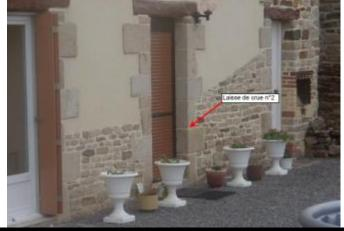
Photo de 2004 lors du relevé du témoignage de la laisse de crues de 1999 sur le mur
