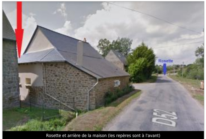
Rosette et arrière de la maison (les repères sont à l'avant)
