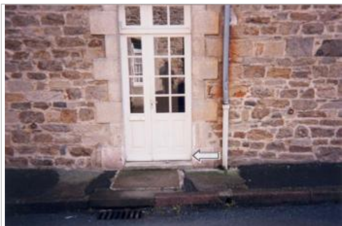
seuil de la porte d'entrée du 2 bis rue du vieux pont
