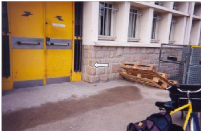
Ancienne entrée de service de la Poste en 2001
