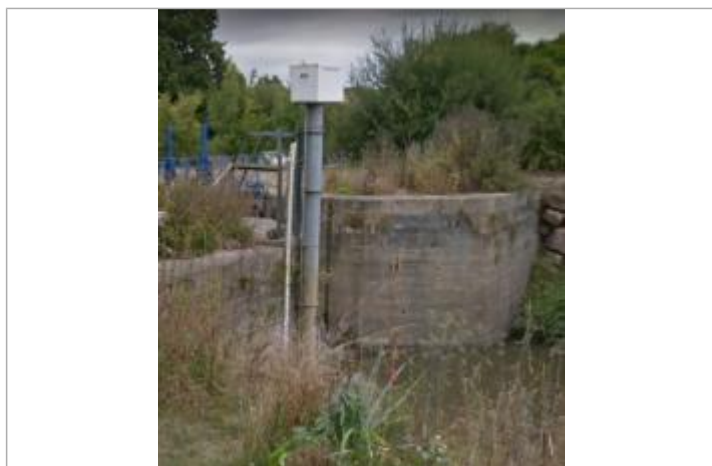
Echelle limnimétrique Aval de l'écluse de Malon
