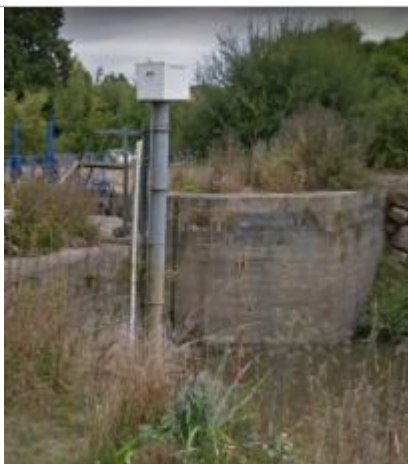
Echelle limnimétrique Aval de l'écluse de Malon
