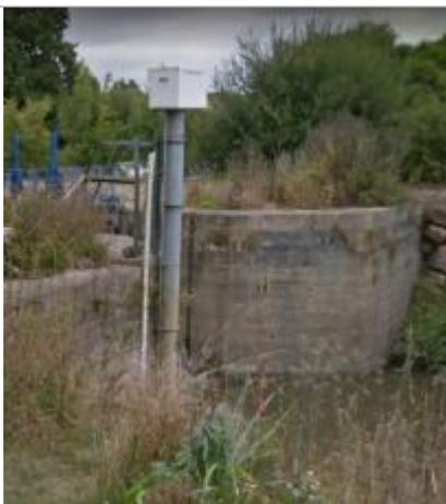
Echelle limnimétrique Aval de l'écluse de Malon
