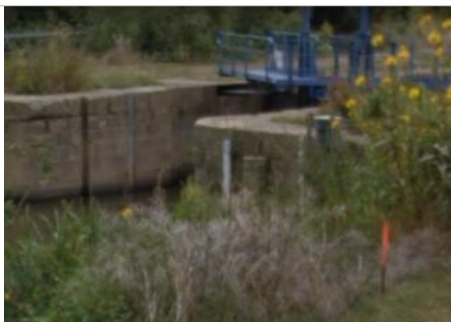
Echelle limnimétrique Amont de l'écluse de Malon
