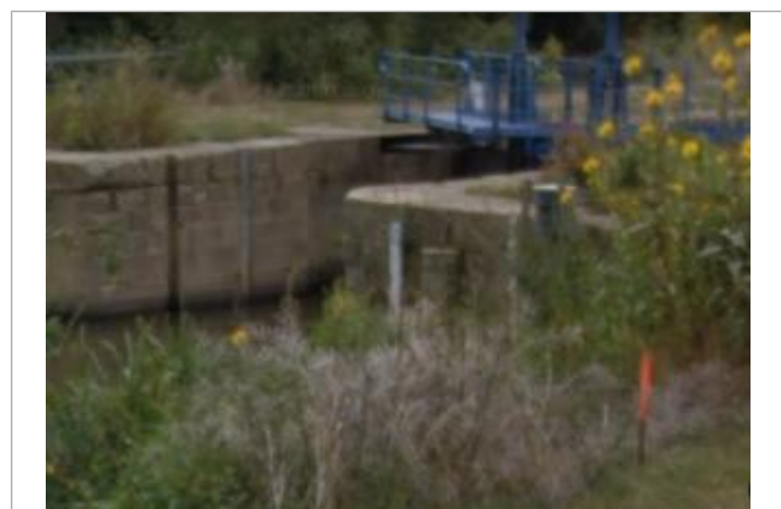
Echelle limnimétrique Amont de l'écluse de Malon
