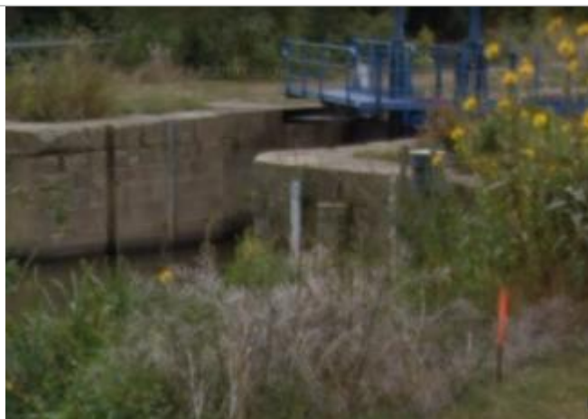
Echelle limnimétrique Amont de l'écluse de Malon
