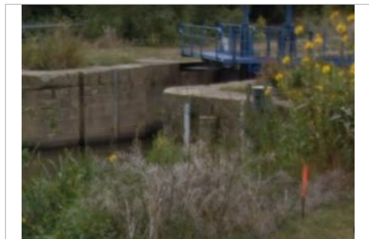
Echelle limnimétrique Amont de l'écluse de Malon
