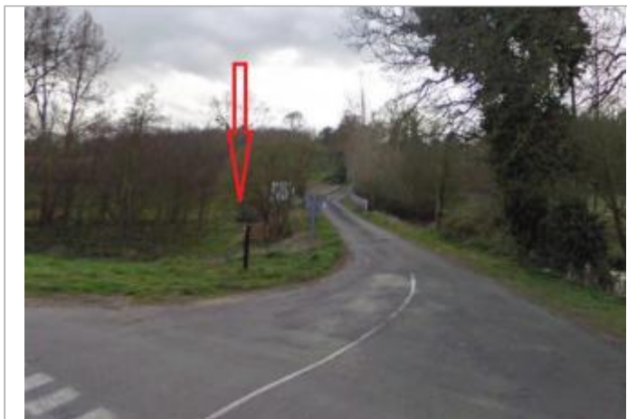
vue globale de l'accès à la station
