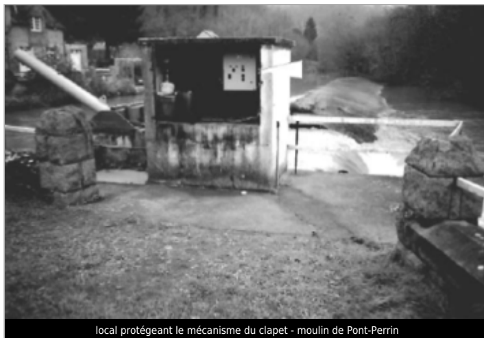
local protégeant le mécanisme du clapet - moulin de Pont-Perrin
