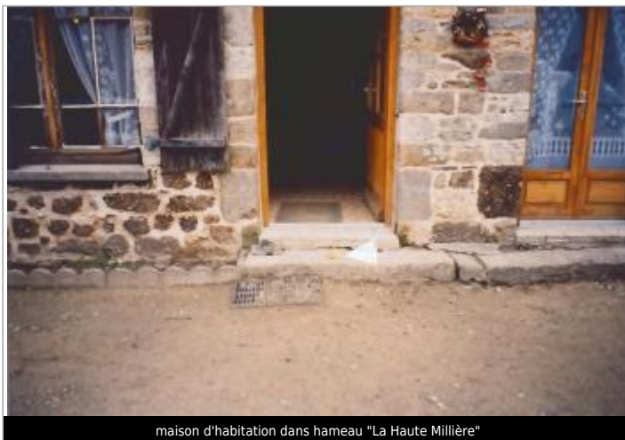
maison d'habitation dans hameau "La Haute Millière"
