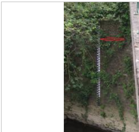
Echelle limnimétrique à l'amont du pont de la RD837 entre Pont-Péan et Chartes de Bretagne
