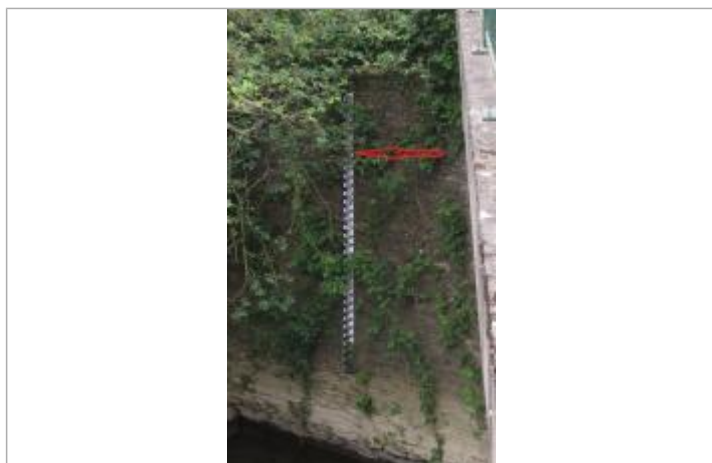
Echelle limnimétrique à l'amont du pont de la RD837 entre Pont-Péan et Chartes de Bretagne
