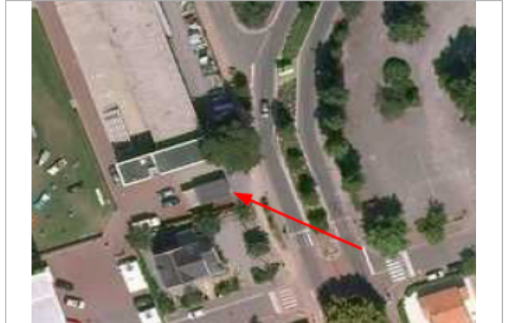
Avenue Joyeuse - Poste EDF
