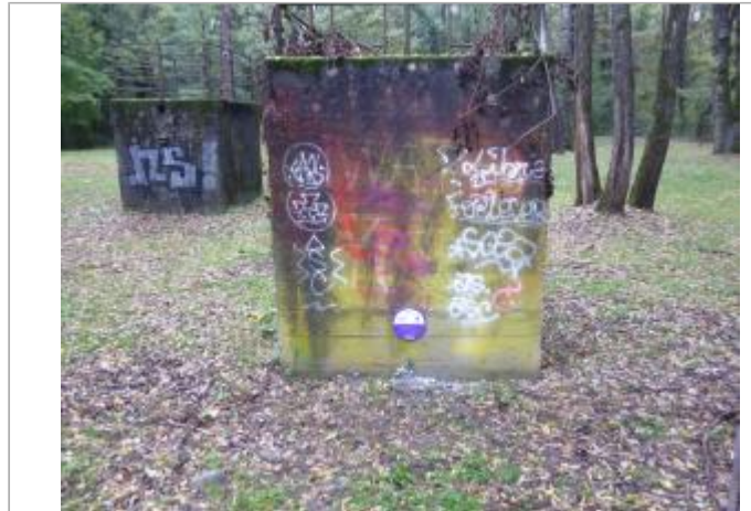
mur du puits de captage
