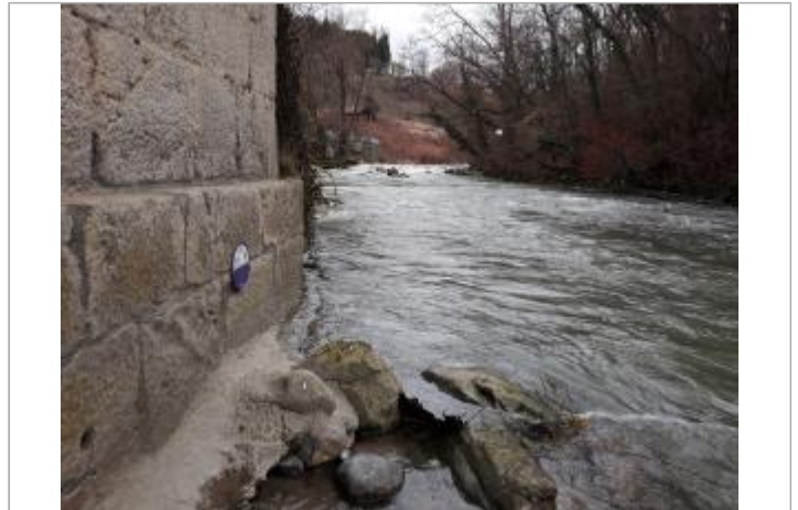
pont de la RD1205 sur la Menoge
