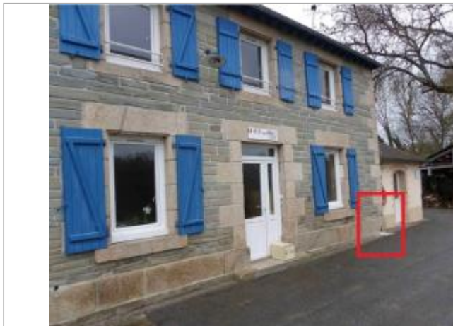
Maison éclusière n°28 de la ville aux Fruglins
