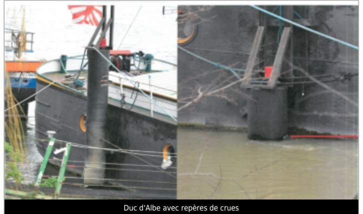
Duc d'Albe avec repères de crues
