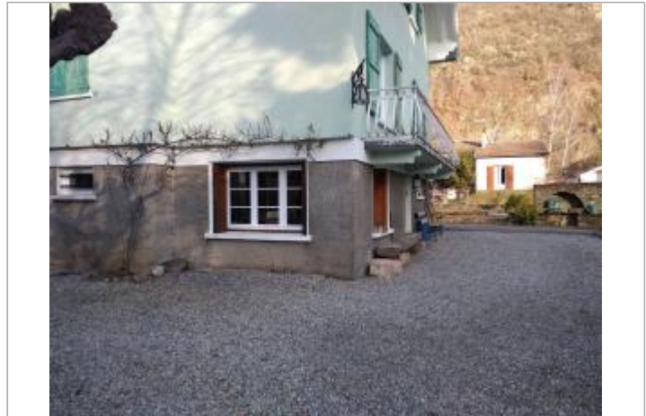
Vue de l'angle de la maison - janv2020
