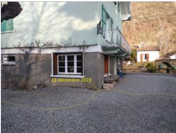
Emprises inondées par la crue - témoignage du propriétaire
