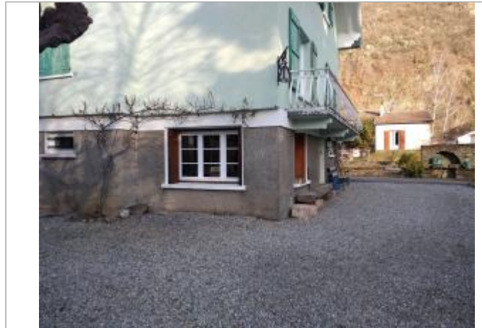
Vue de l'angle de la maison - janv2020
