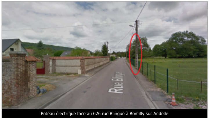
Poteau électrique face au 626 rue Blingue à Romilly-sur-Andelle
