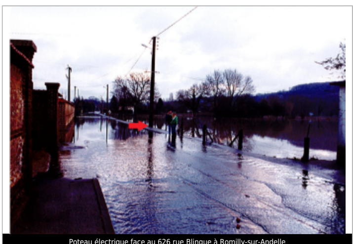
Poteau électrique face au 626 rue Blingue à Romilly-sur-Andelle
