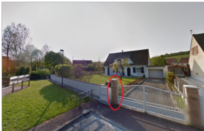
Pilier en brique à gauche du portail du 29 résidence les prairies à Martin-Eglise.
