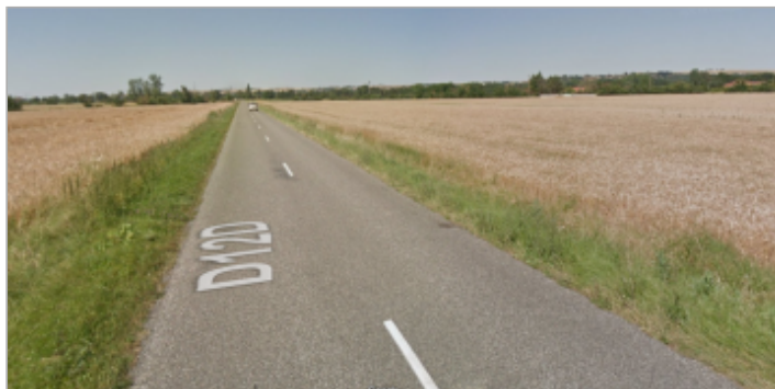
Vue de la RD12D vers Auterive - juin 2018 avant la crue [Google(c)]
