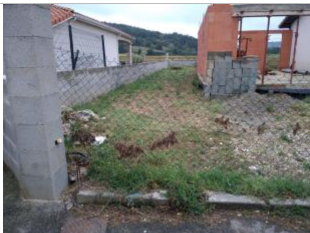
Laiesses de crues dans les grillages de clôtures et sur les murs
