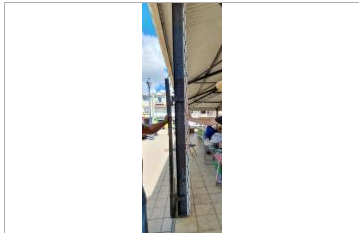
Poteau de mesure des hauteurs de crue (06/11/15; 27/08/19; 31/10/19)
