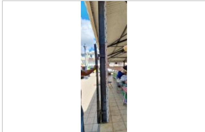
Poteau de mesure des hauteurs de crue (06/11/15; 27/08/19; 31/10/19)
