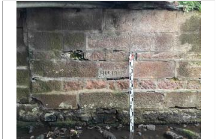
Culée latérale du pont RD426 avec indicateur TN +0.83, selon mire
