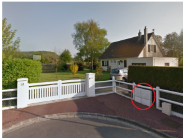
armoire réseaux située au 19 résidence les prairies à Martin-Eglise
